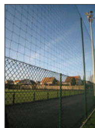
Habillage grillage Sur poteau acier
